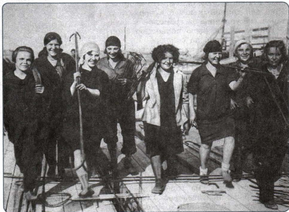
Женская строительная бригада. 1931 г.
